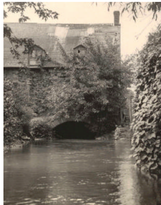
Cette photo et la suivante: moulin à eau situé à la côte Sainte-Catherine. Il aurait disparu lors de la construction de la Voie maritime.
