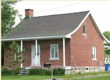
sur la photo ci-jointe le toit à larmiers recouvert de tuiles métalliques imbriquées et les briques posées en soldats sur les linteaux. L'acheteur, qui est un promoteur immobilier, devant se soumettre aux nouveaux règlements concernant les installations sanitaires, pourrait éventuellement être tenté de démolir la demeure puisqu'il n'a pas l'intention de l'habiter. Voilà un dossier à suivre de près.
