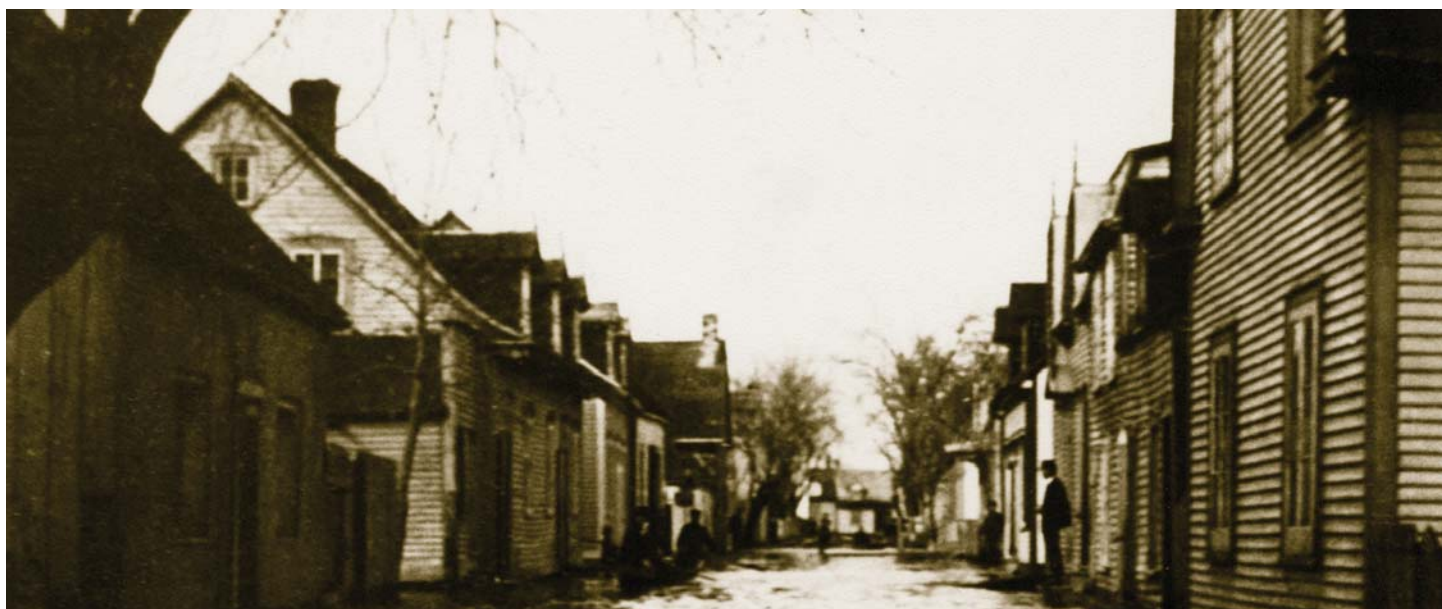
Inondation sur la rue Saint-Jacques en 1929 : vue complète de la rue Saint-Jacques depuis la rue Saint-Louis jusqu'au chemin de Saint-Jean.
