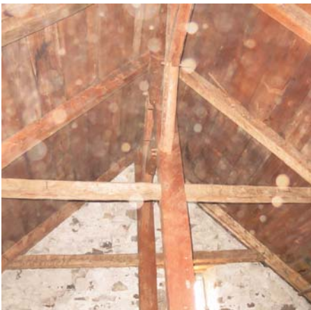
Maison Brossard : la charpente de bois
